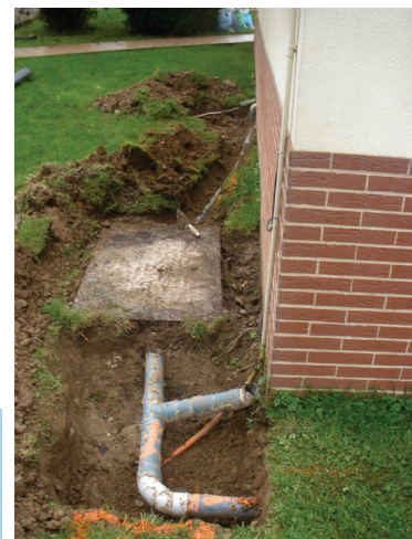
Dégagement de la fosse toutes eaux avant sa déconnexion
