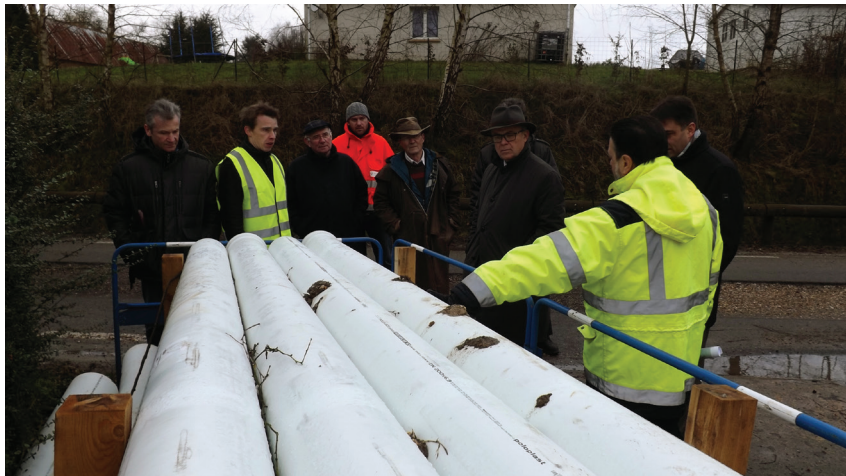
Visite de chantier
