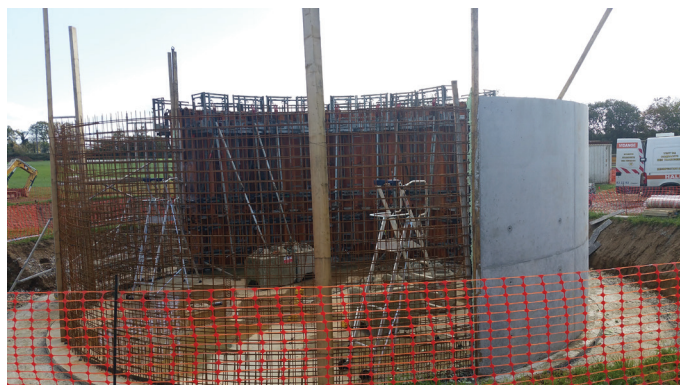
Coulage des voiles
