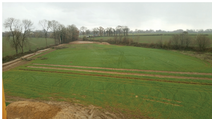
Aménagement de l'aire d'infiltration
