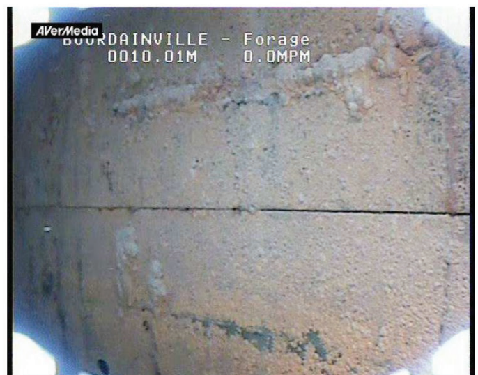
Jonction tube lisse – crépine = top crépine
