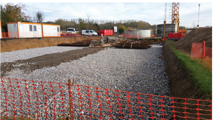
Terrassements pour les lits de roseaux
