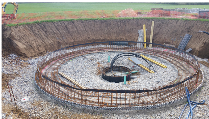
Dalle du bassin d'aération
