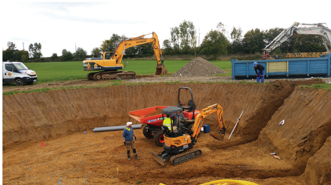
Terrassement du bassin d'aération
