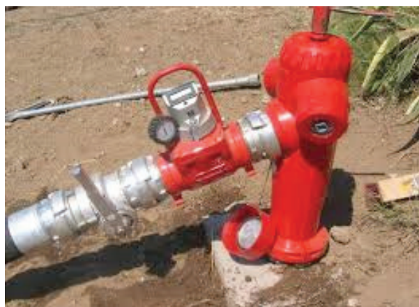
Test de débit d'un poteau d'incendie
