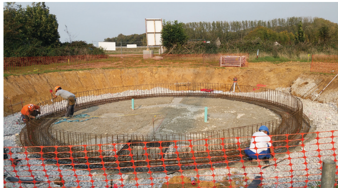
Ferrailage de la dalle du clarificateur
