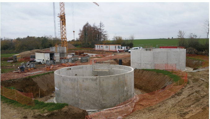
Vue d'ensemble du chantier
