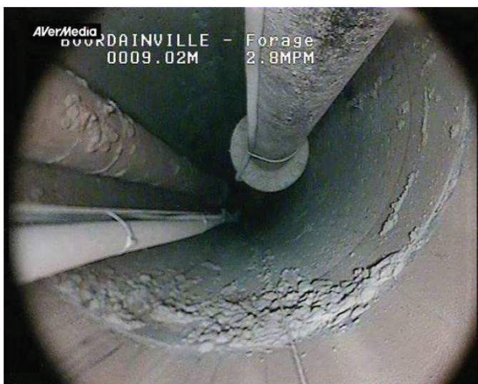
Tube lisse télescopé modérément corrodé
