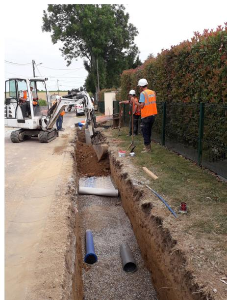
*Pose de la canalisation d'eau potable (bleue) et de la canalisation d'eaux usées (en gris) en tranchée commune*
