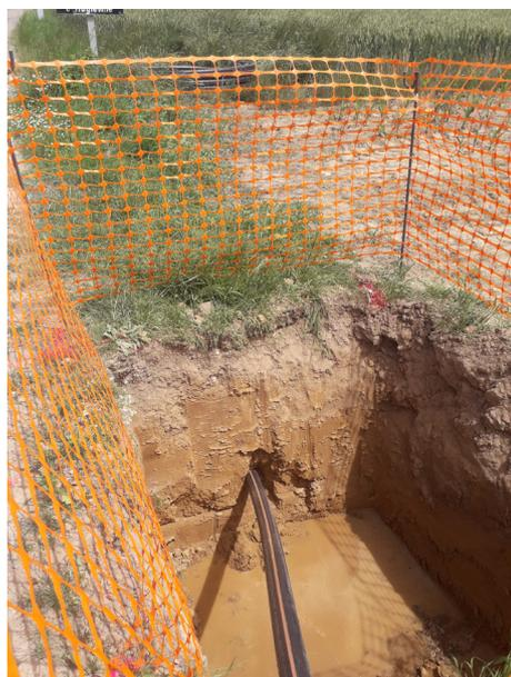
*Canalisation de refoulement implantée en forage dirigé*
