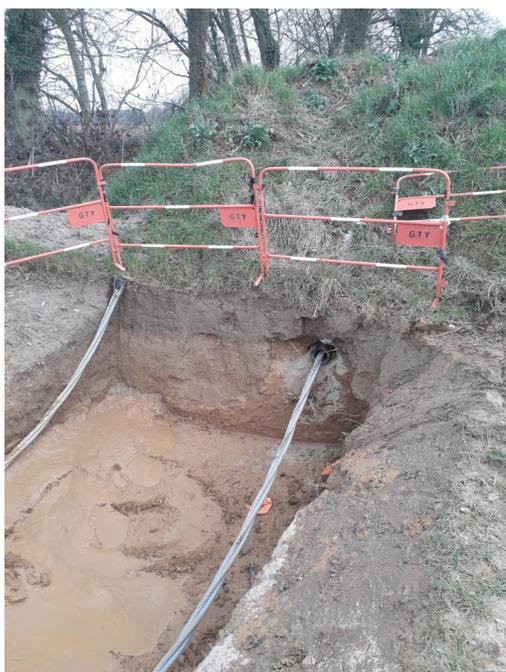
*Câble électrique sortant du fourreau passé par forage dirigé*
