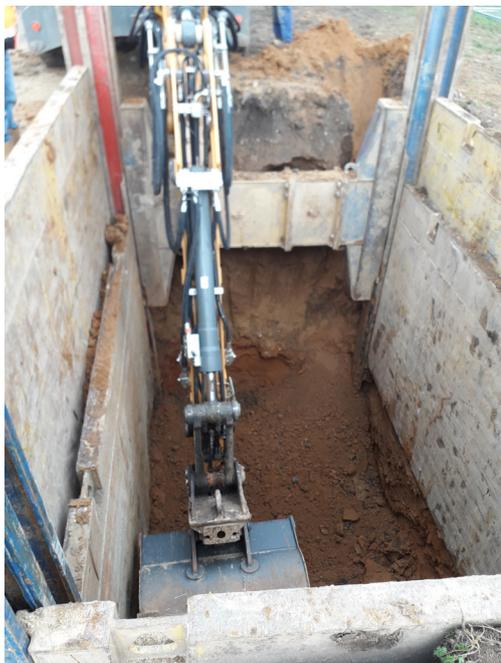
*Creusement et fortification d'une des 2 fosses nécessaires au fonçage*
