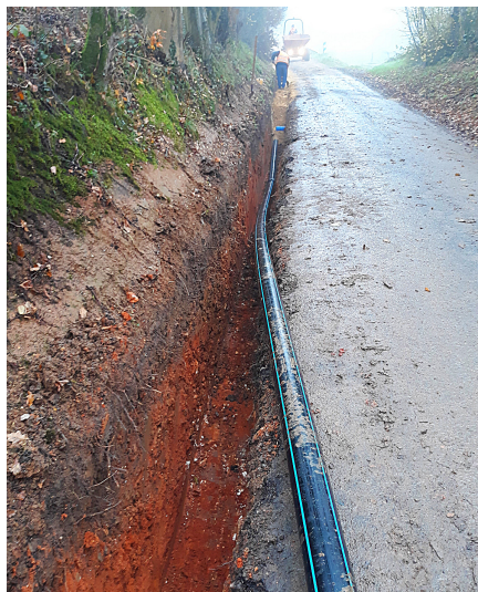
Travaux à Ancretieville Saint Victor
