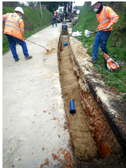
Travaux à Grémonville
