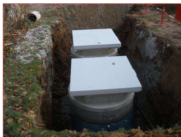
Pose d'un poste de relèvement des eaux usées
