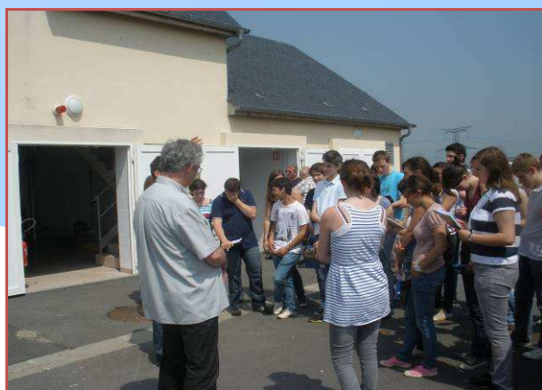
Visite de la station d'épuration de Yerville-Bourdainville
