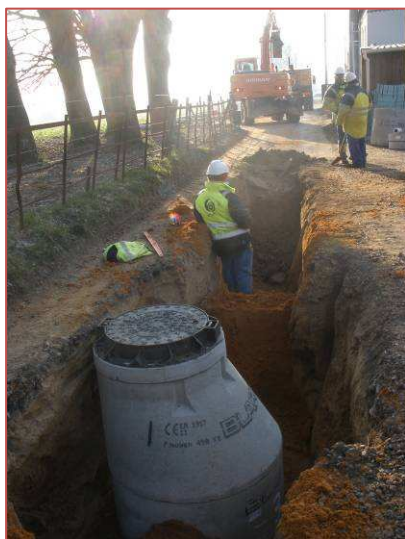
Pose de la canalisation et des regards d'assainissement
