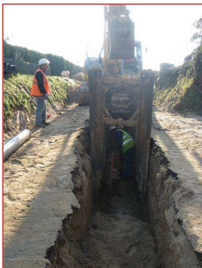
Pose de la canalisation et des regards d'assainissement
