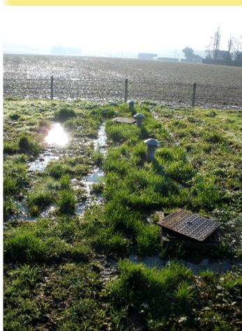
Les lagunes d'épuration de Saint Ouen du Breuil fonctionnent en surcharge (494 EH raccordés pour une capacité nominale réelle de 380 EH) et présentent par conséquent de nombreux dysfonctionnements. En outre, la vétusté de l'installation impose à minima une remise aux normes des ouvrages (prétraitement, canal de comptage) sinon leur remplacement par une nouvelle filière.
