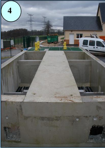
**4. Le traitement tertiaire :** dans cet ouvrage les eaux claires issues du clarificateur subissent une étape de traitement de finition. Les dernières impuretés sont traitées par un traitement physico-chimique (coagulation / floculation) et décantées.
