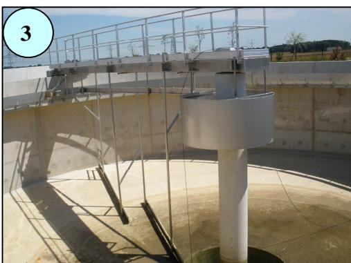
**3. Le clarificateur :** dans cet ouvrage les boues décantent par gravité et sont ainsi séparées de l'eau claire. Le pont racleur, par rotation, permet de regrouper les boues au centre de l'ouvrage. Ces boues seront extraites et dirigées soit vers le bassin d'aération (étape de recirculation) soit vers les lits de roseaux.
