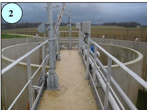
**2. Le bassin biologique :** dans cet ouvrage les eaux prétraitées sont mises en contact avec l'oxygène (qui vient des surpresseurs) et des bactéries qui se développent naturellement dans l'ouvrage. Ce processus biologique permet de dégrader la pollution présente dans l'eau brute. C'est l'étape la plus importante dans le processus de traitement de l'eau.
