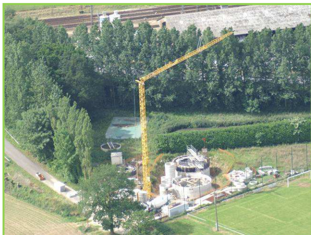
Vue aérienne du chantier
