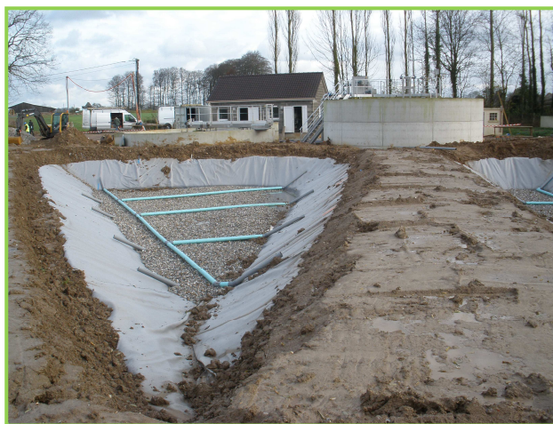
Mise en place des lits de roseaux
