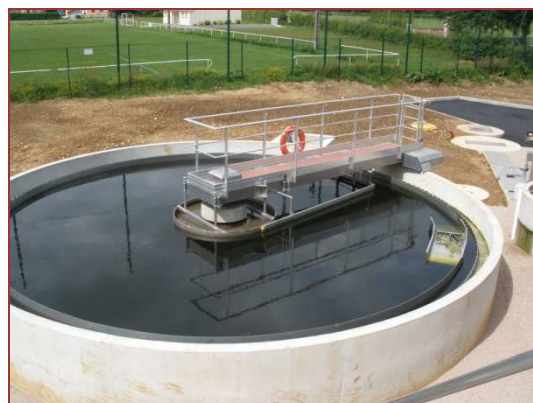
Ouvrage de décantation mise en eau
