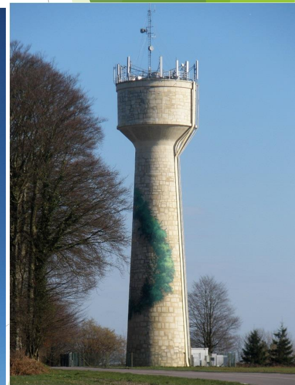
Réservoir de Bourdainville RN29
