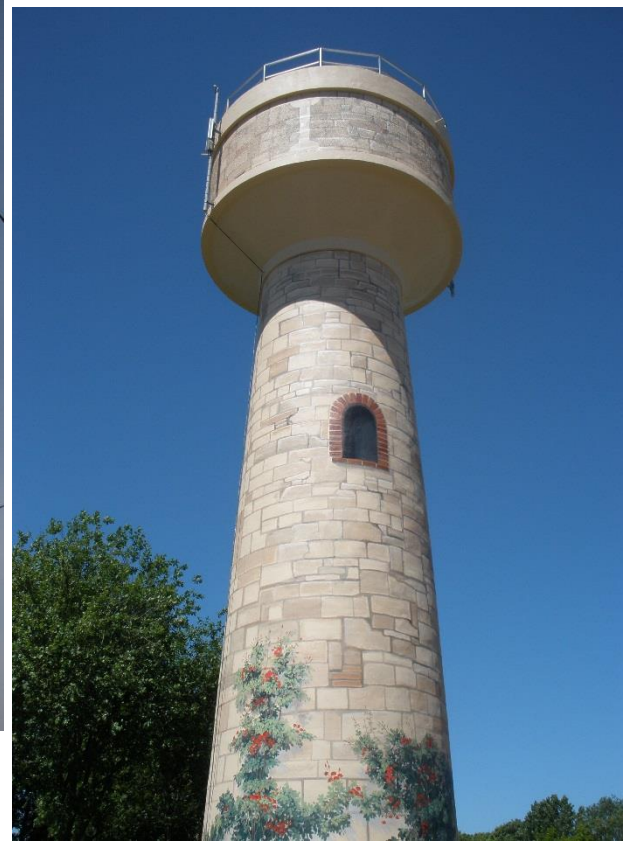
Réservoir de Bourdainville bourg
