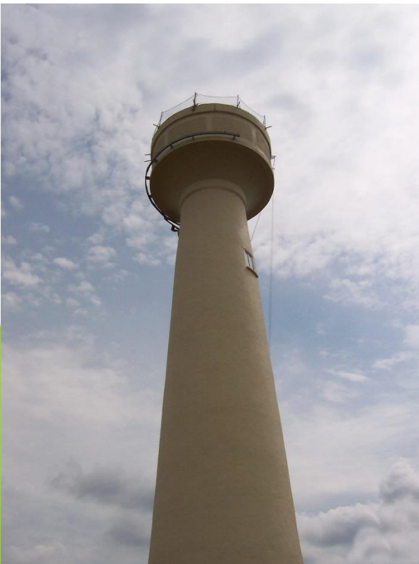
Réservoir de Saint Martin aux Arbres
