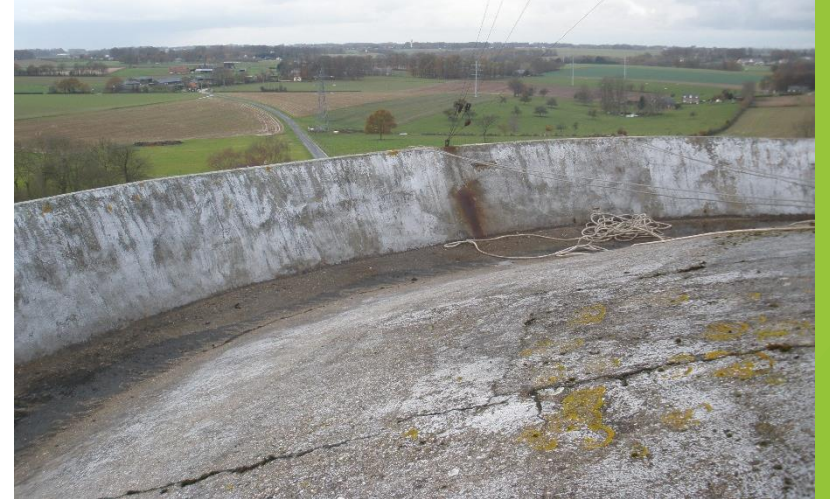
Dôme du réservoir d'Ancretiéville Avant/Après
