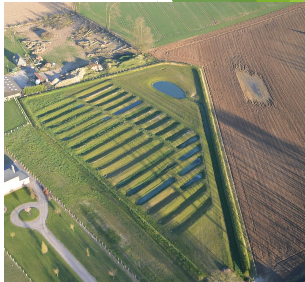
2013 : Aire d'infiltration des eaux traitées
