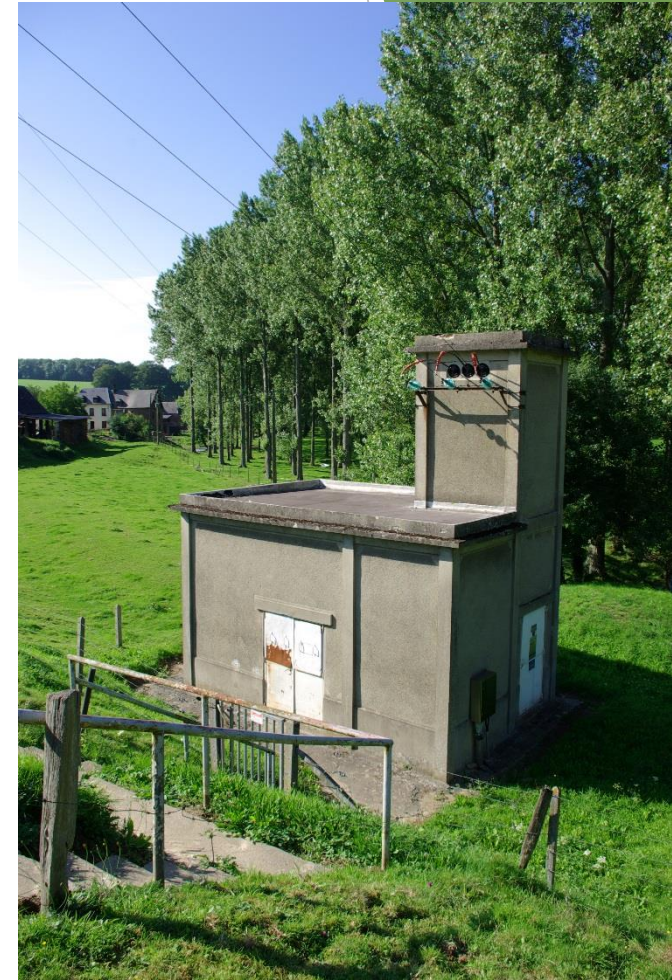
Forage de Bourdainville (qui n'est utilisé qu'en secours car la ressource est très turbide)
