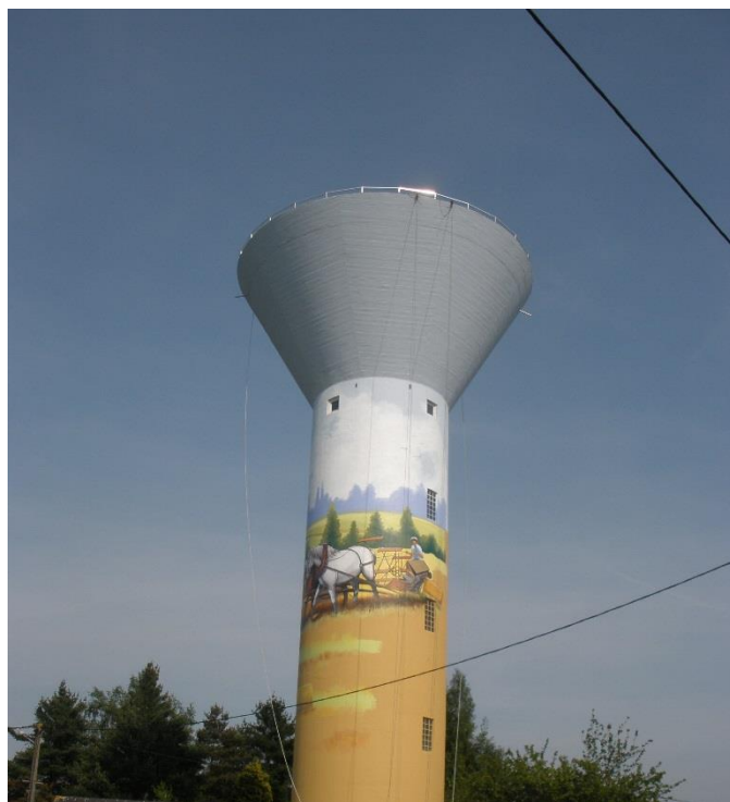
Réservoir d'Ancretiéville St Victor
