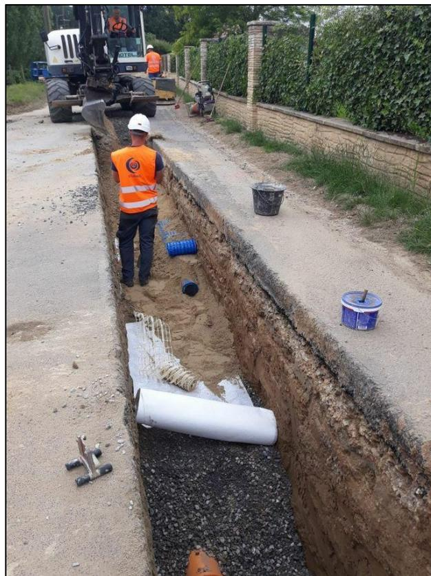
*Pose de la conduite d'eau potable et de la canalisation d'assainissement dans une tranchée commune*
